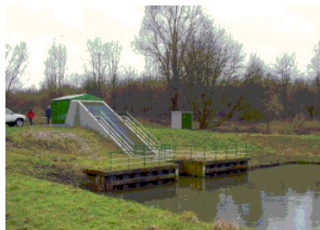
Foto 1: links: het Zuigerplasmemaal. Water wordt opgepompt uit de Houtribtocht en stroomt vervolgens naar de Zuigerplas en het stedelijke gebied (onder).
