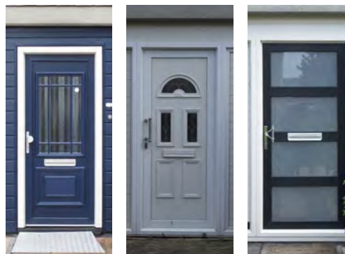
links en midden: vervanging gevelelementen. rechts: diversiteit in voordeuren.
