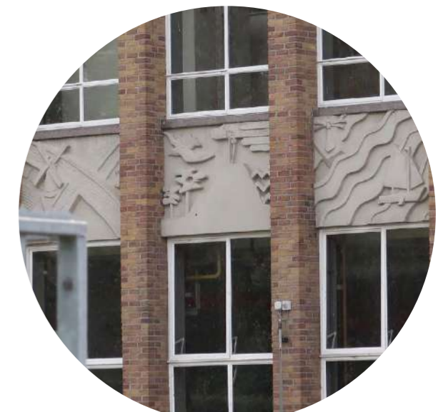
betonnen elementen tussen kozijnen
