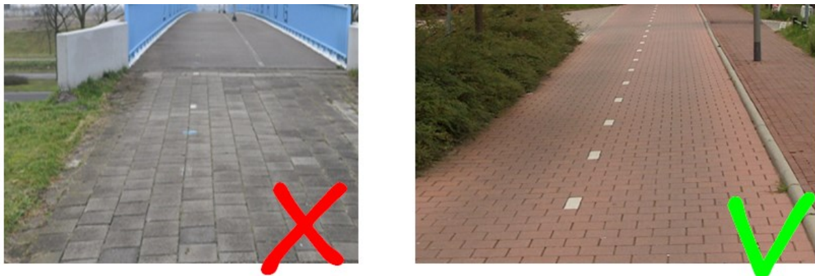
Figuur 5: Foutieve en juiste toepassing van een open verharding
