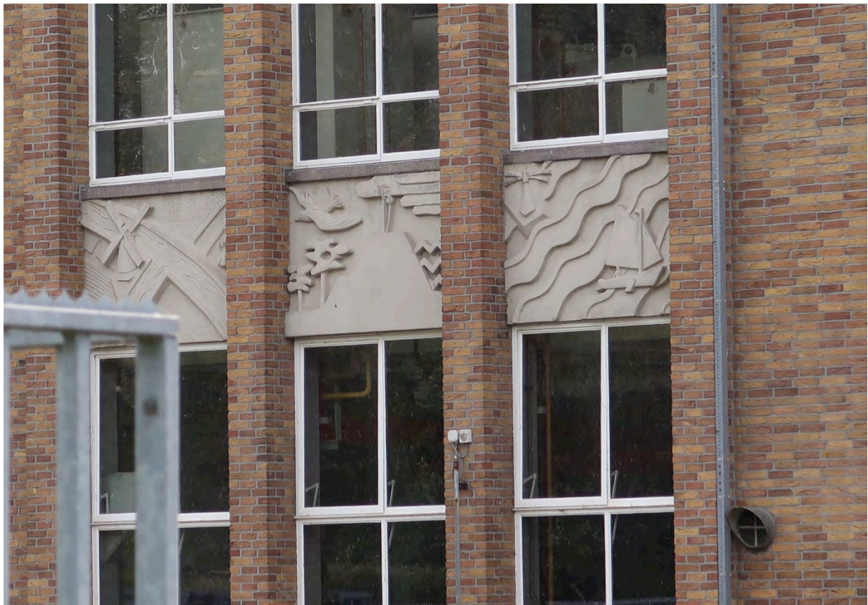
De kunstwerken in de kopgevel aan de zuidzijde (boven) en noordzijde (onder).
