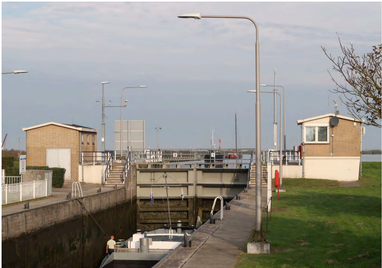
De bedieningsgebouwtjes op het bovenstroomse sluishoofd.
