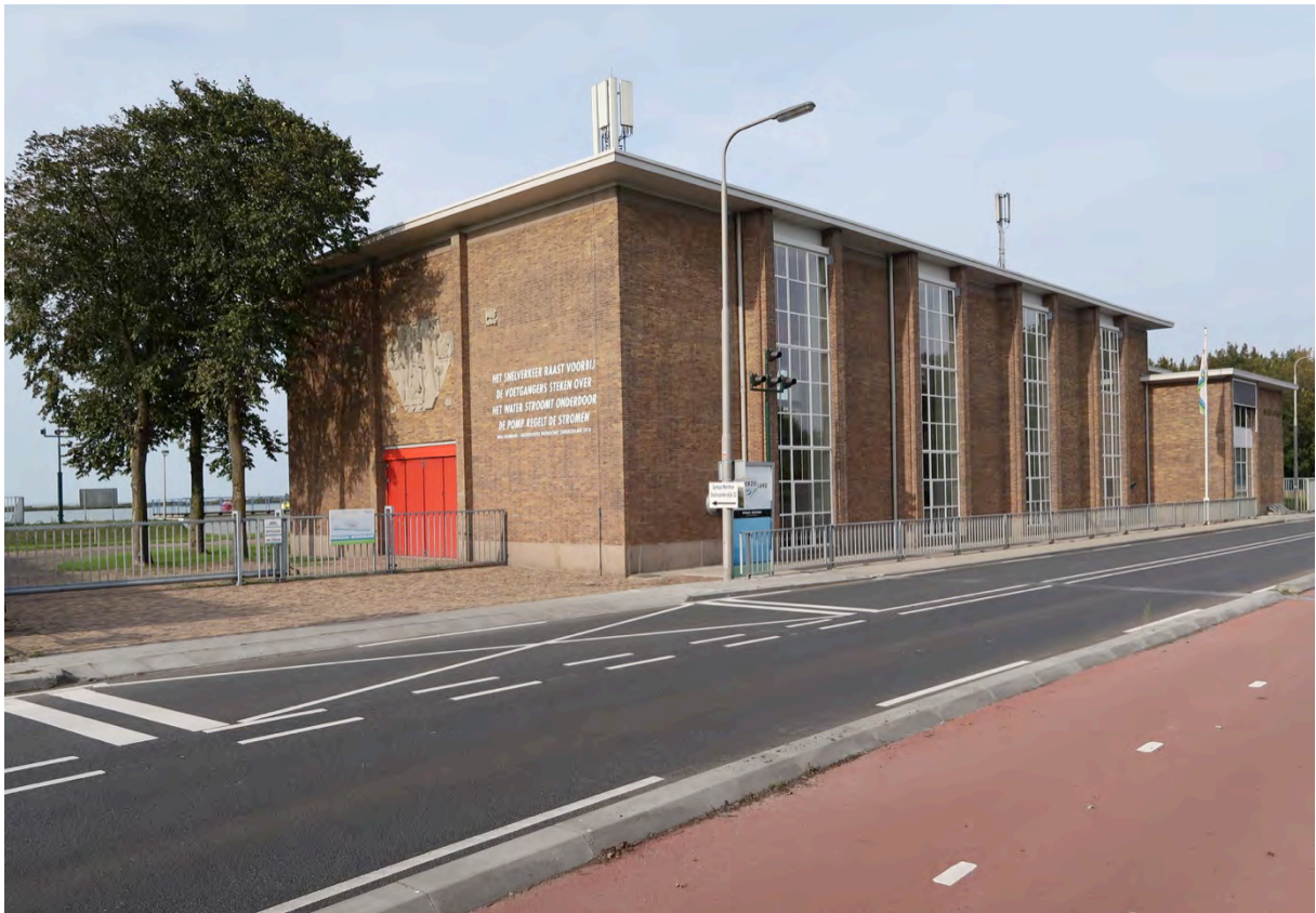
Het gemaal Wortman aan de zijde van de Houtribweg.
