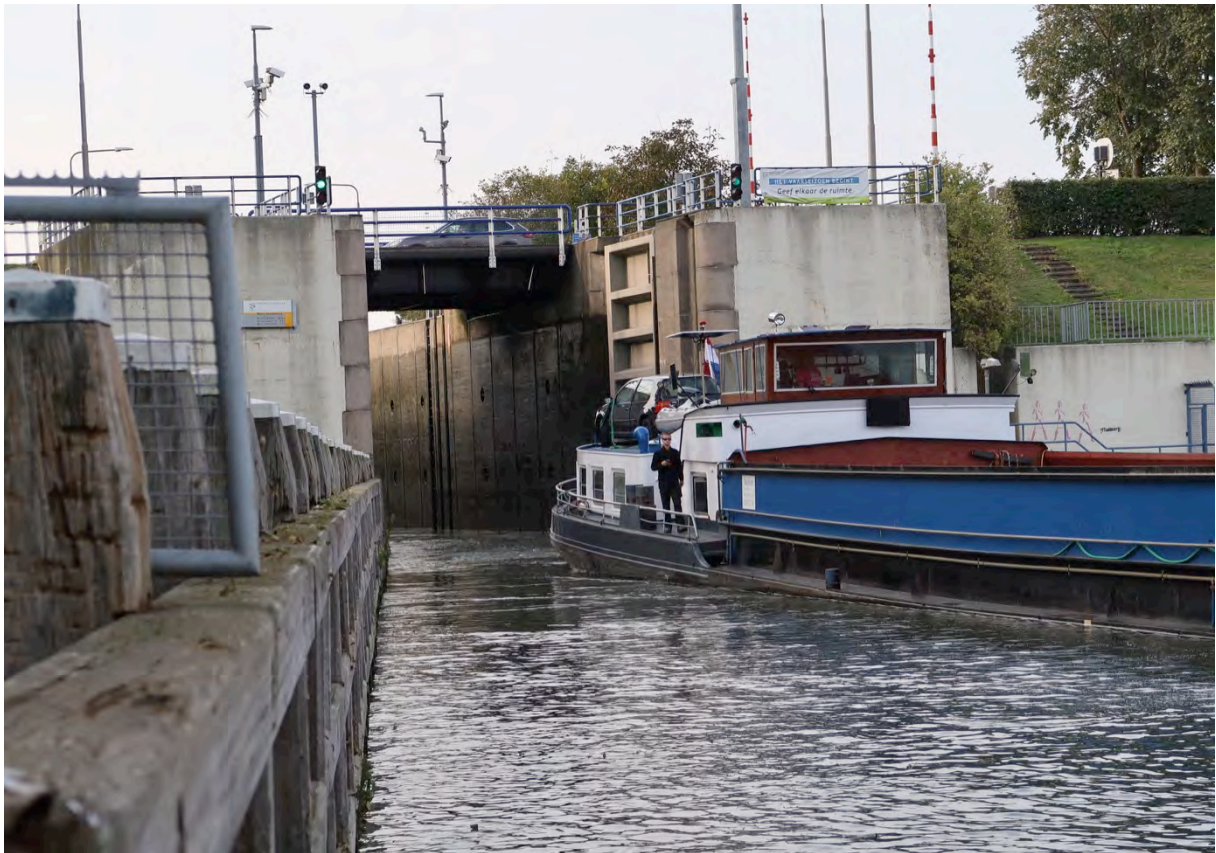
De skutkolk en het benedenstroomse sluishoofd.
