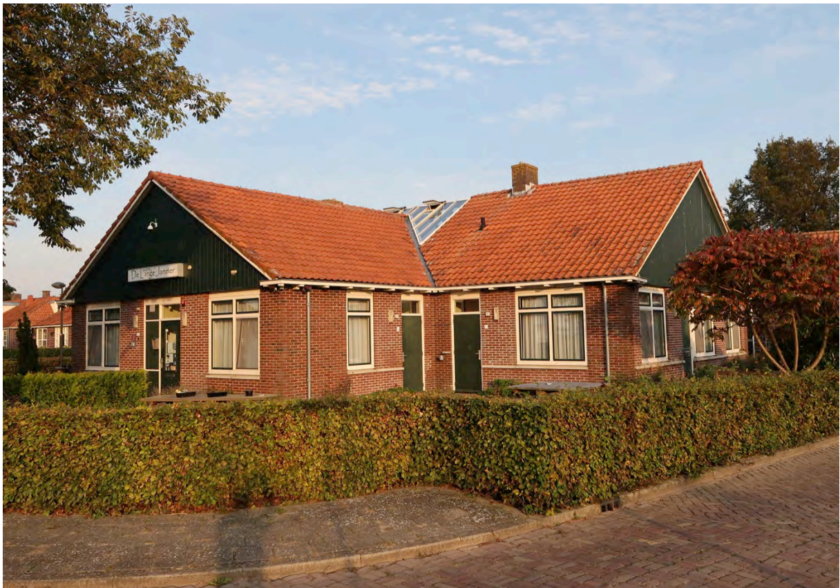
De forse nieuwbouw ter plaatse van het voormalige kantoortje.
