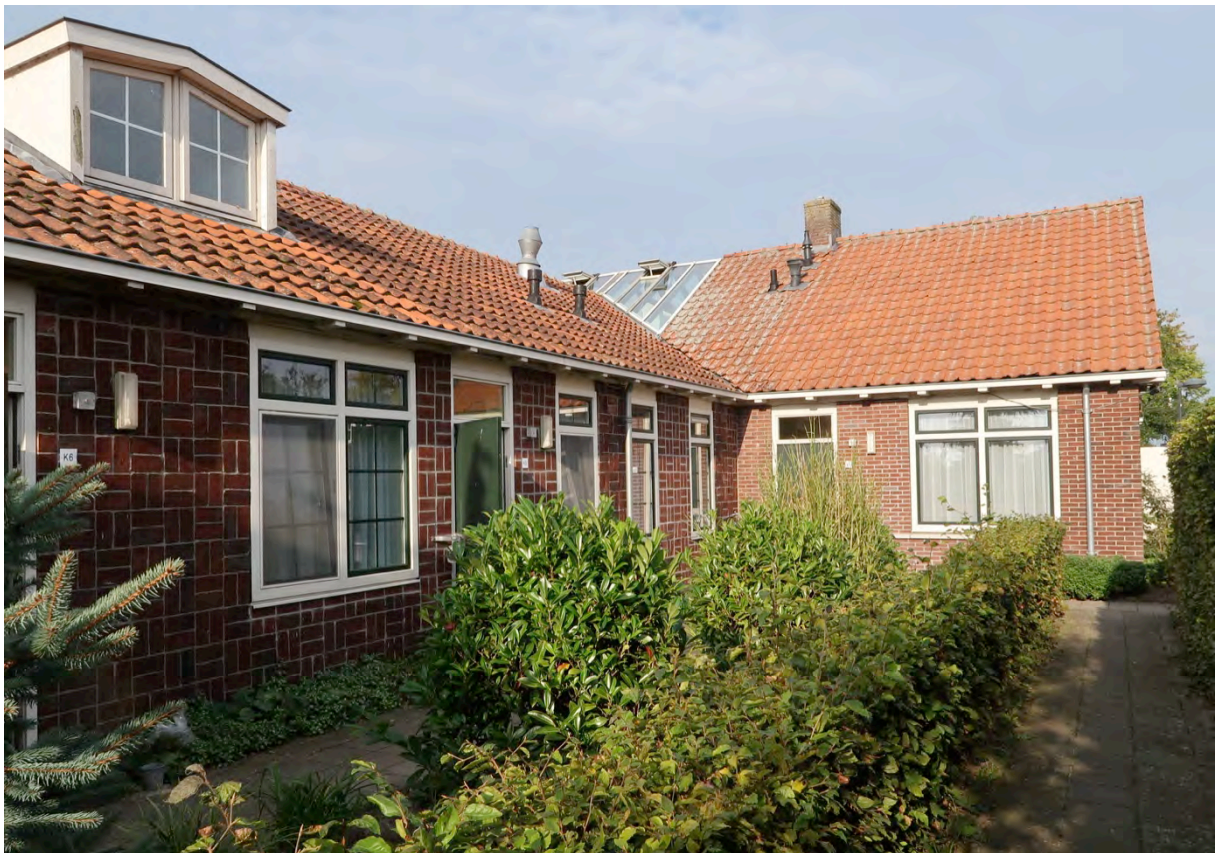
Het voormalige keukengedeelte.
