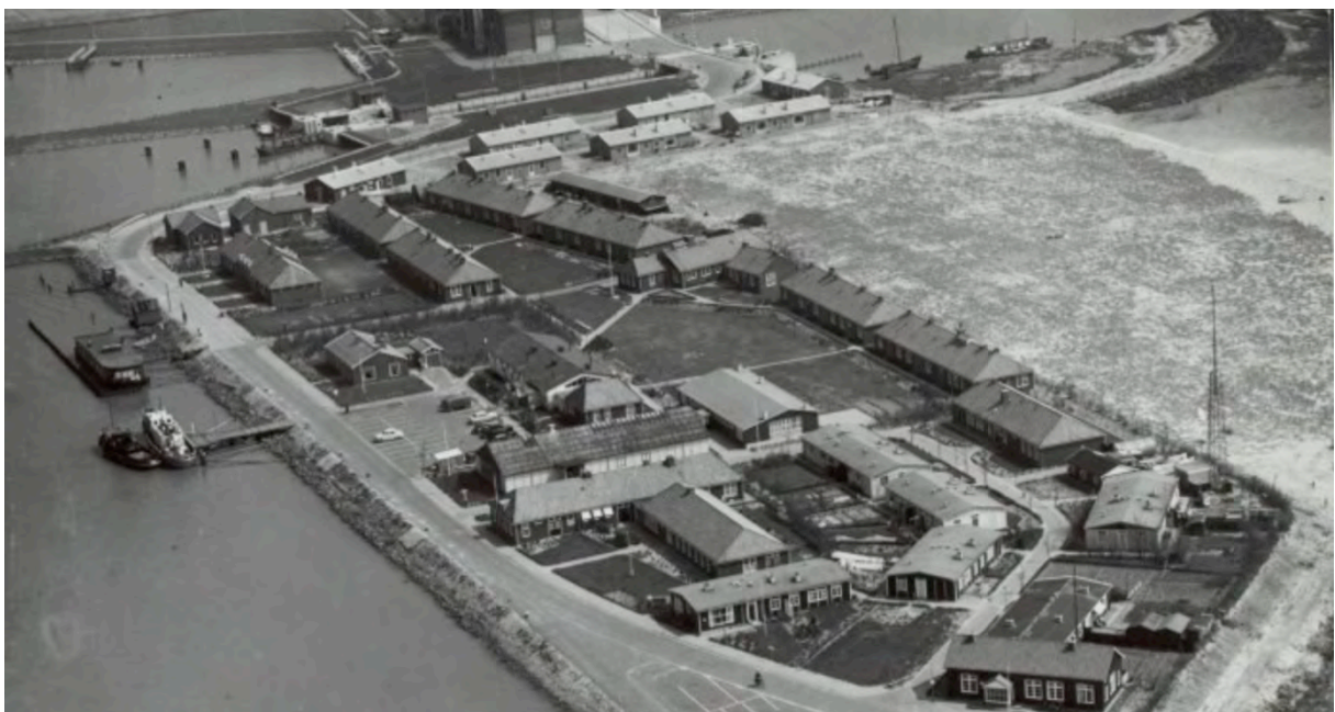
Het werkeiland nadat de polder was droog gevallen.
